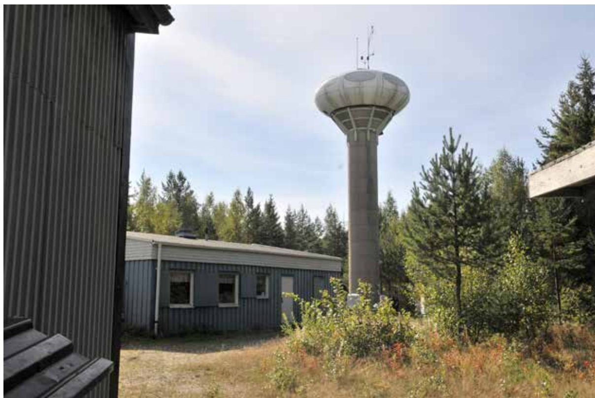
Bild 13. Mättorn nr 1 på Noran vid Tönnebro. Tornet står vid kontors och verkstadbyggnader som hör till skjutfältet.
