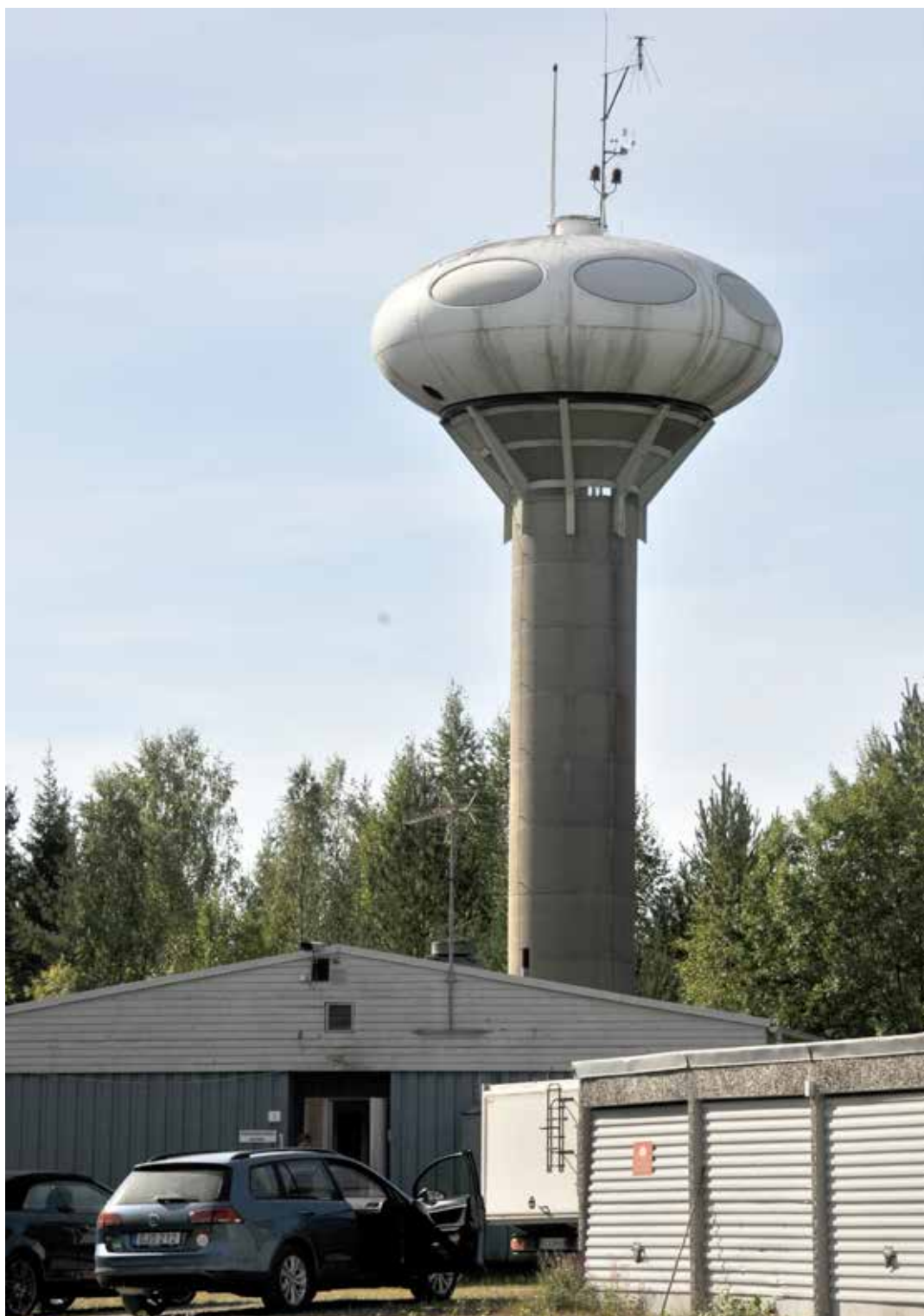
Bild 17 Mättorn nr 1 på Noran vid Tönnebro. På tornets tak syns varningsljus för flygtrafiken samt antenner och åskledare. Från tornen kommunicerade man via radio med flyget samt markpersonalen.
