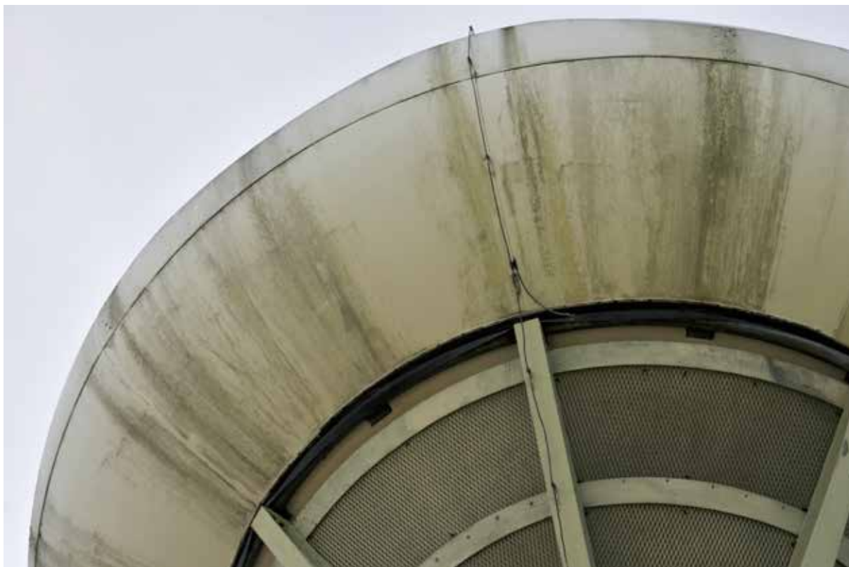
Bild 2. Mättorn 1, det norra tornet på Noran vid Tönnebro sett underifrån. Metallkorgen till höger bär Futurohusets nedre skal. Skarvarna mellan plattelementen syns som svaga linjer.
