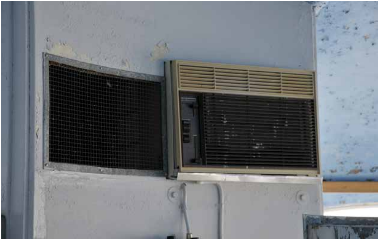
Bild 46. Mättorn nr 2 på Noran vid Tönnebro. Värmeanläggning/luftkonditionering.
