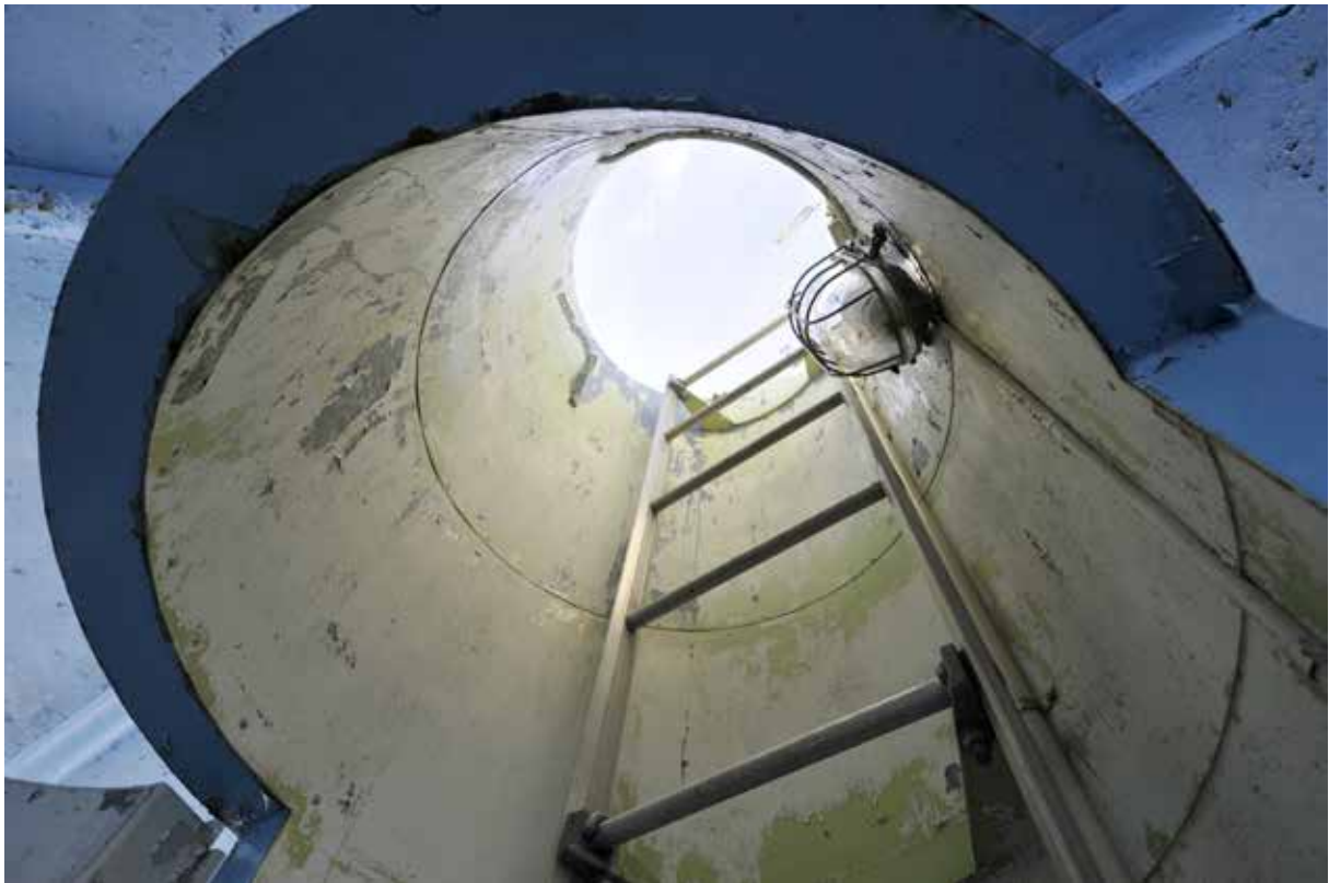
Bild 42. Mättorn nr 2 på Noran vid Tönnebro. Uppgång till Futurohusets tak. Till vänster interiörens blå kulör, i tuben vit färg och ett underliggande grönt färgskikt.
