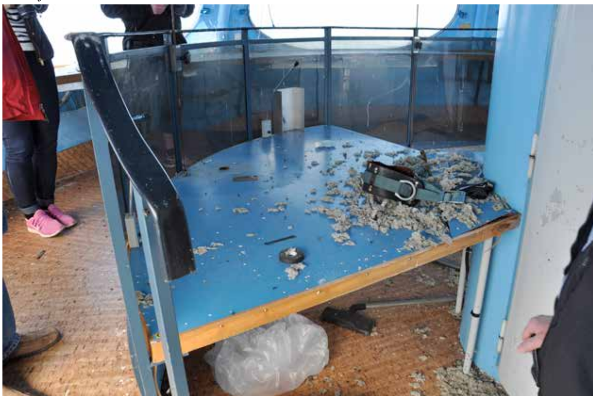
Bild 24. Interiör av mättorn nr 1 på Noran vid Tönnebro. På denna nedre arbetsyta karterades träffarna
