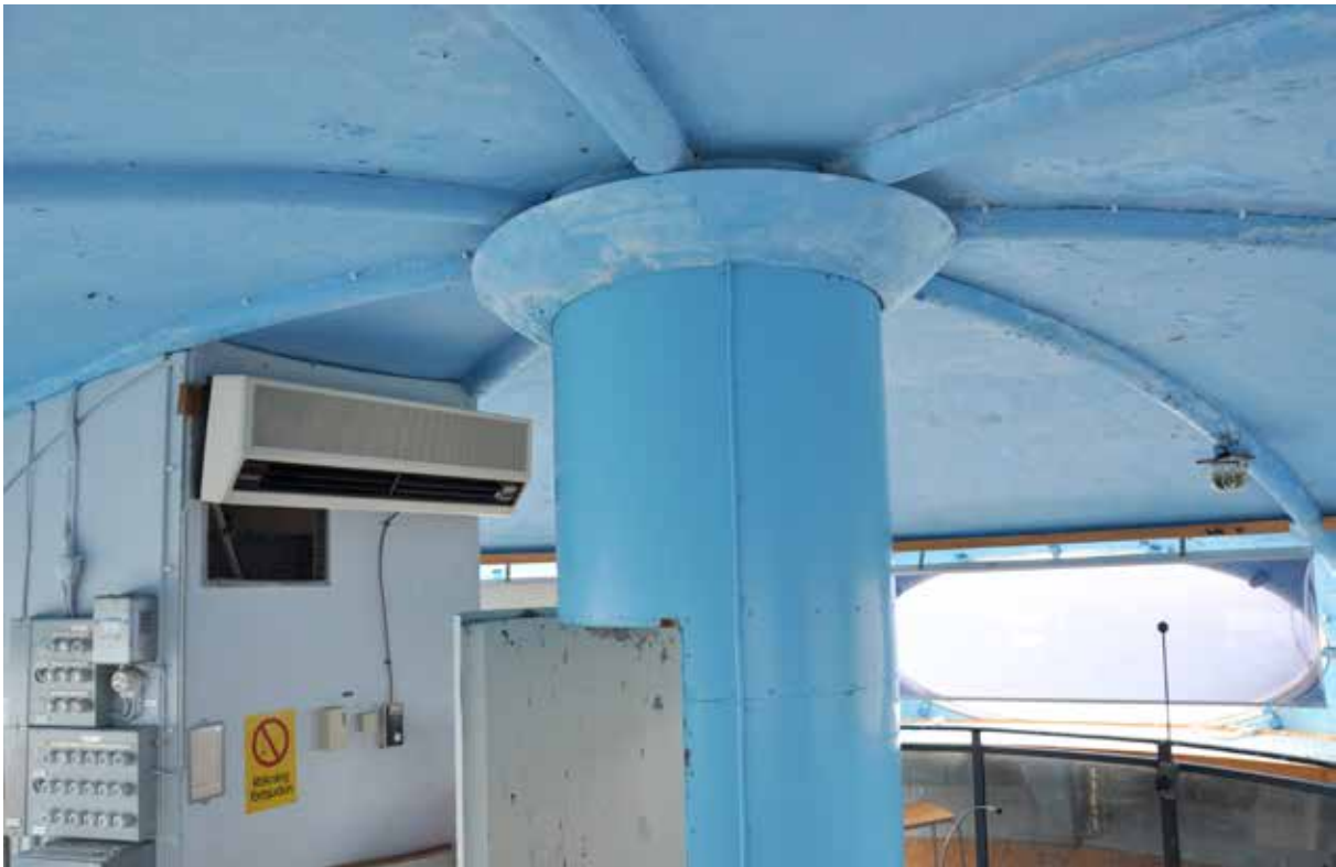
Bild 25. Mättorn nr 1 på Noran vid Tönnebro. I bakgrunden den aircondition som installerades för att sänka temperaturen i tornet sommartid
