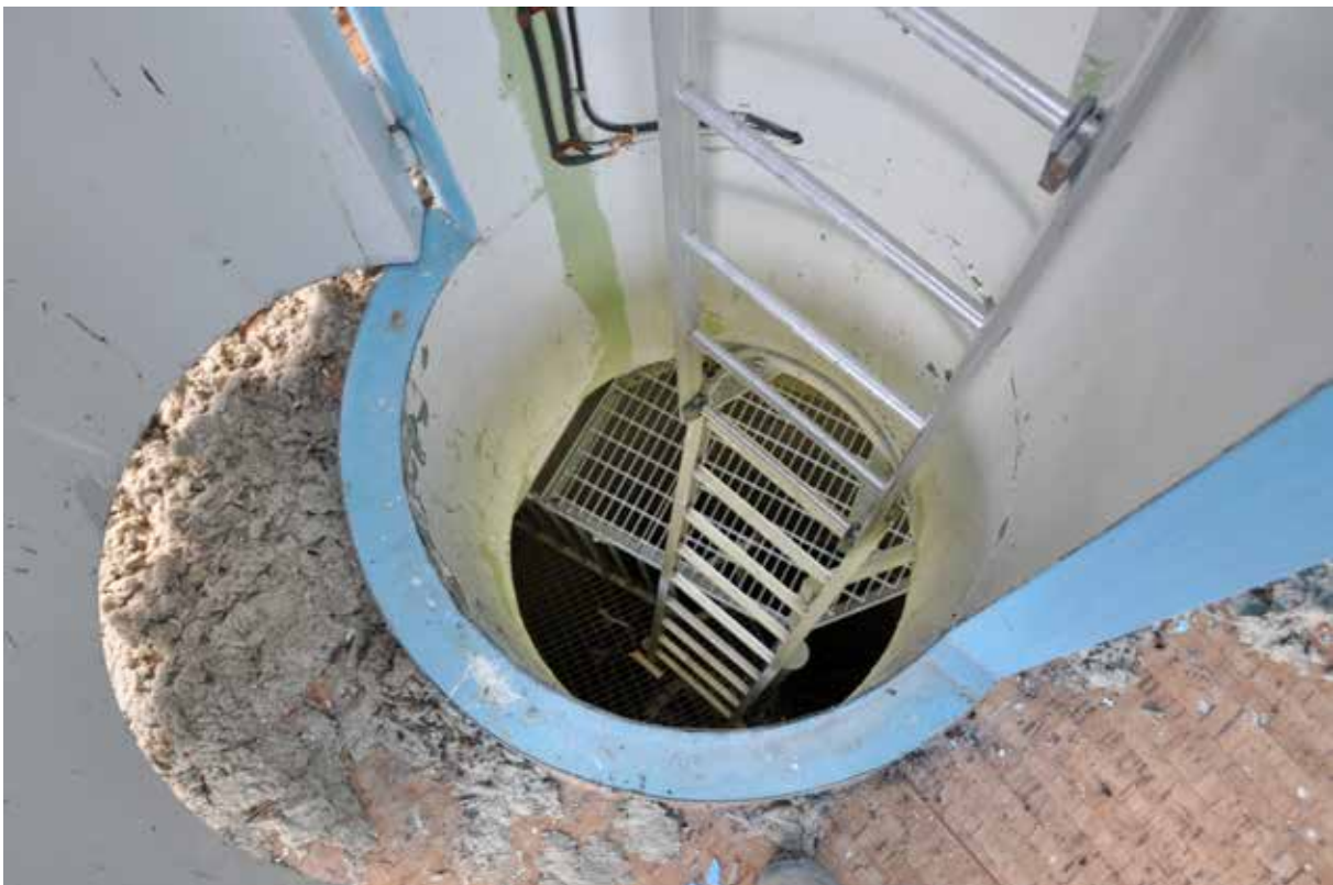
Bild 26. Mättorn nr 1 på Noran vid Tönnebro. Tuben sedd från tornrummet ner mot trappan.
