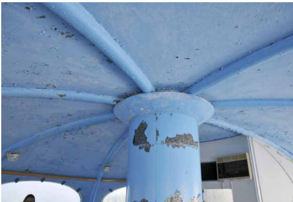
Bild 40. Mättorn nr 2 på Noran vid Tönnebro. Byggnadens konstruktionselement möts i en skarv täckt med rundade lister. I toppen på tuben finns även ett skålformat bräm. Troligen hanterar dessa detaljer eventuella läckage mellan elementen.
