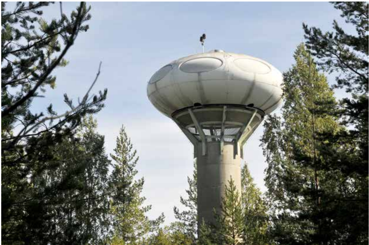
Bild 28. Mättorn nr 2 på Noran vid Tönnebro. Under tornet anas den avsats där kameran var monterad
