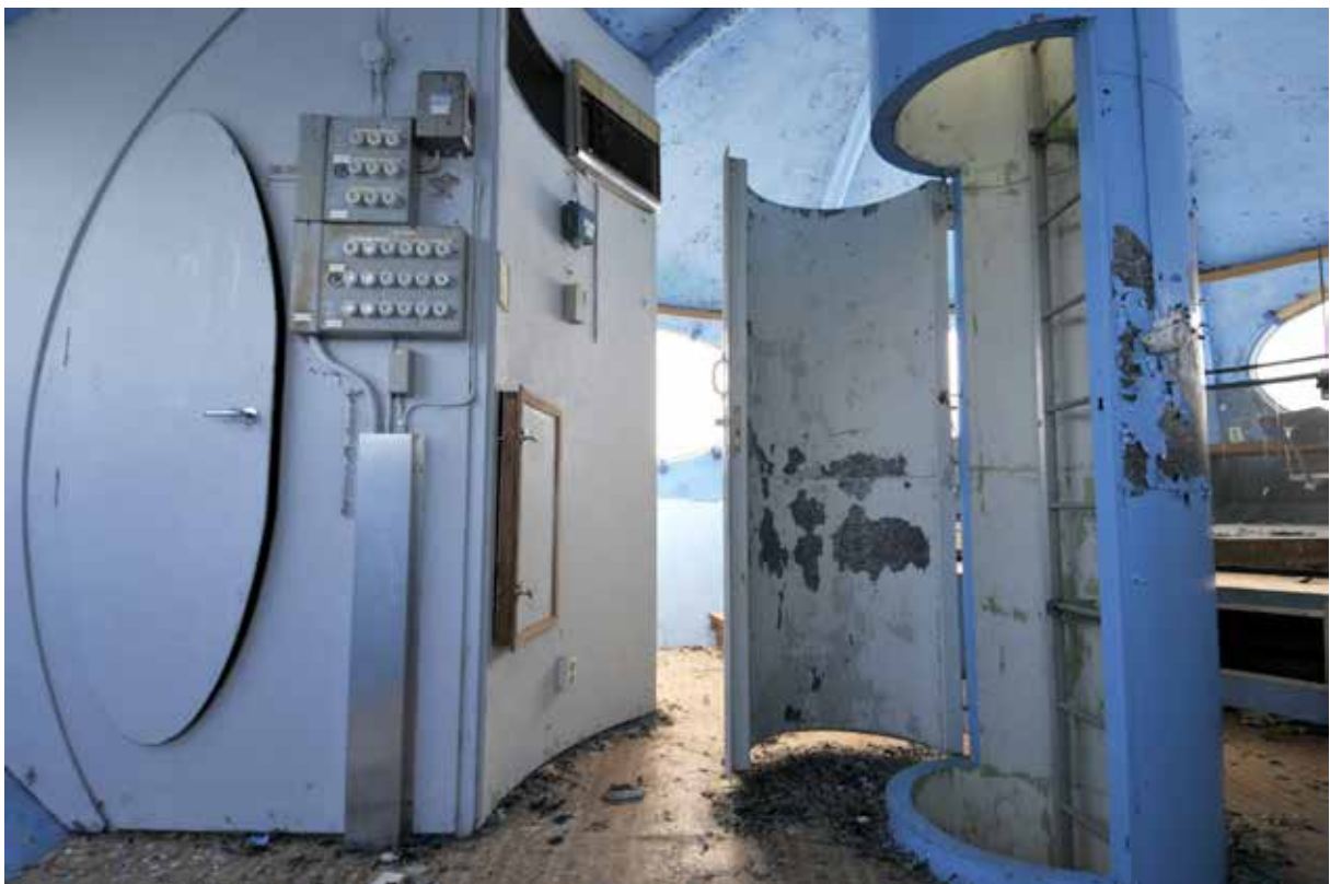
Bild 38. Mättorn nr 2 på Noran vid Tönnebro. Interiör. El- och värmecentral till vänster i bild. Ingången via den centrala tuben till höger.
