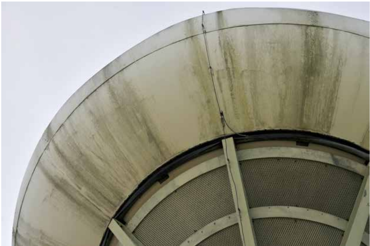
Bild 18. Mättorn nr 1 på Noran vid Tönnebro. Korgen under Futurohuset var ursprungligen öppen, sträckmetallgallret är sekundärt.
