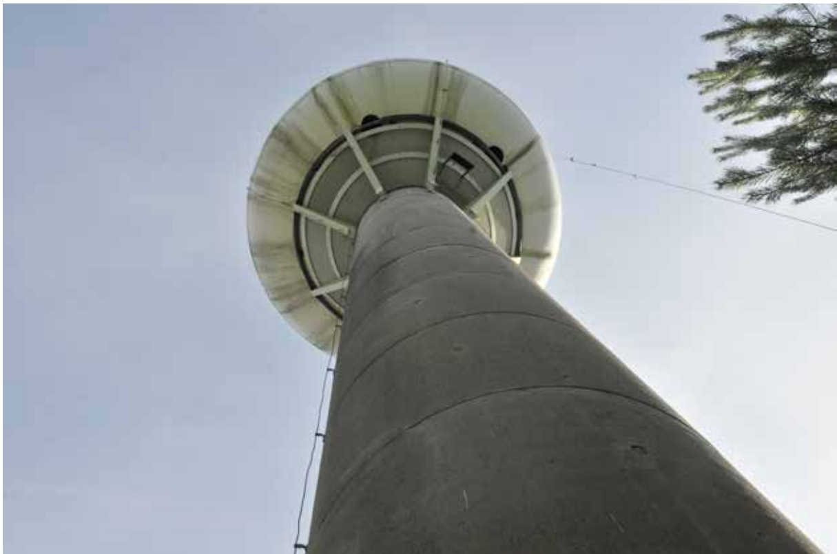
Bild 19. Mättorn nr 1 på Noran vid Tönnebro. Tornet består av ett antal cementrummor som är staplade.
